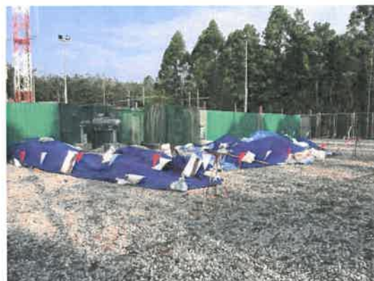
รูปที่ 2-5 การปิดคลุมหน้าดินป้องกันการฟุ้งกระจายของฝุ่นละออง
