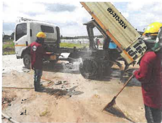
รูปที่ 2-6 การล้างล้อก่อนออกจากพื้นที่โครงการ
