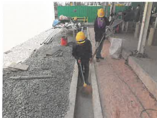
รูปที่ 2-32 การติดตั้งแผ่นกรองที่รางระบายน้ำ และการทำความสะอาดรางระบายน้ำ
