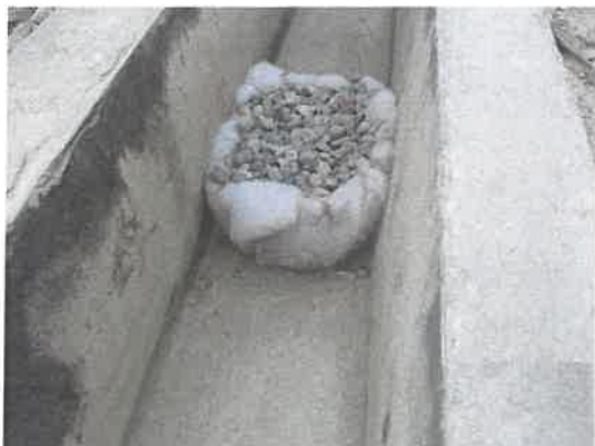
รูปที่ 2-32 การติดตั้งแผ่นกรองที่รางระบายน้ำ และการทำความสะอาดรางระบายน้ำ
