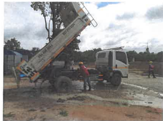
รูปที่ 2-6 การล้างล้อก่อนออกจากพื้นที่โครงการ
