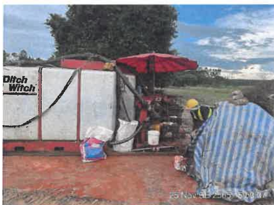
รูปที่ 2-35 การผสมโซเดียมเบนโทไนท์ เพื่อใช้ในการเจาะลวด
