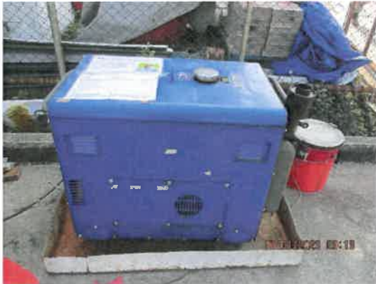
รูปที่ 2-23 ถาดรองรับน้ำมันสำหรับป้องกันการรั่วไหล
